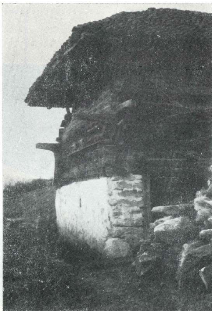
Сл. 17 Рашчлањености по висини на камен, дрво и ћерамиду јасно изражава функционалну оправданост примене та три различита материјала.
