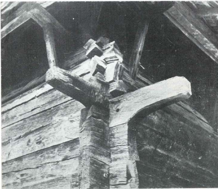
Сл. 14 Почетак закривљавања зидова обележена је испустима брвана на угловима који су дати више од пола метра.
