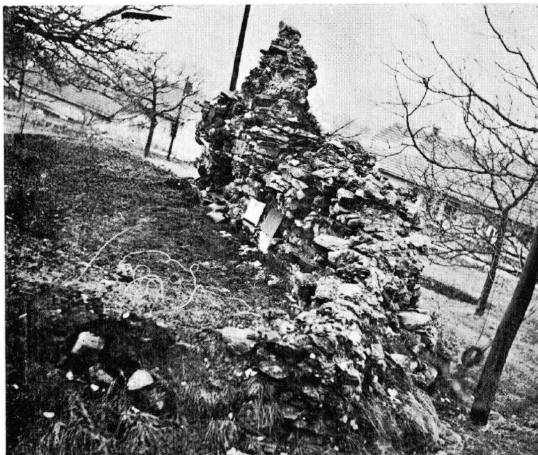
Сл. 2 Рушевине цркве на Руднику, изглед са источне стране
