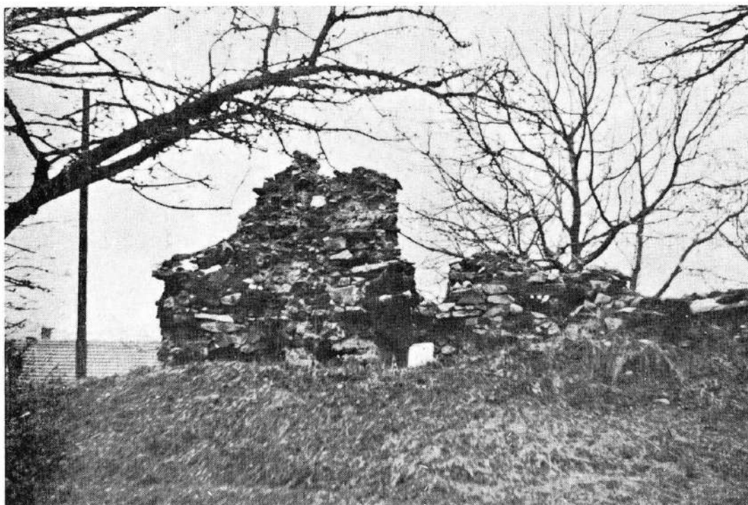
Сл. 1 Рушевине цркве на Руднику, општи изглед
