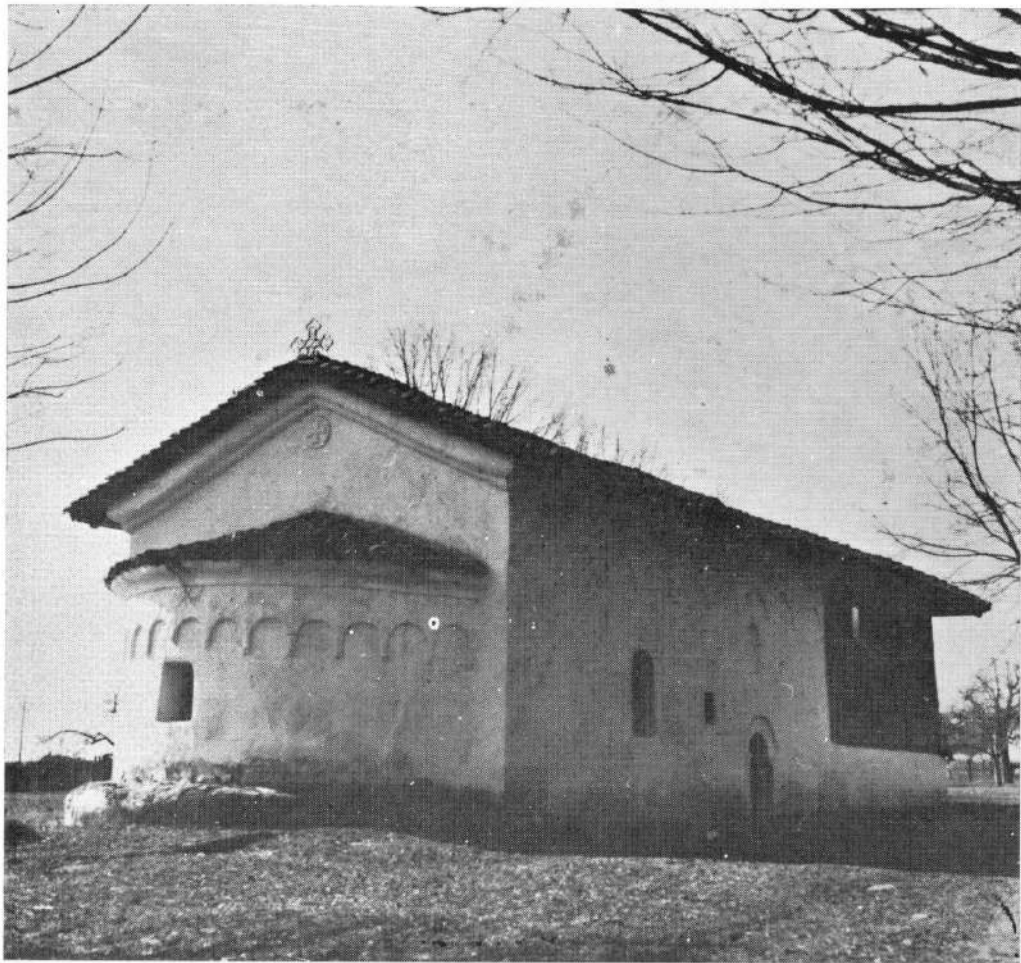
Сл. 1 Бресница, стара црква, општи изглед
