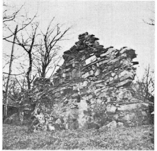
Сл. 4 Рушевине цркве на Руднику, изглед северног зида
