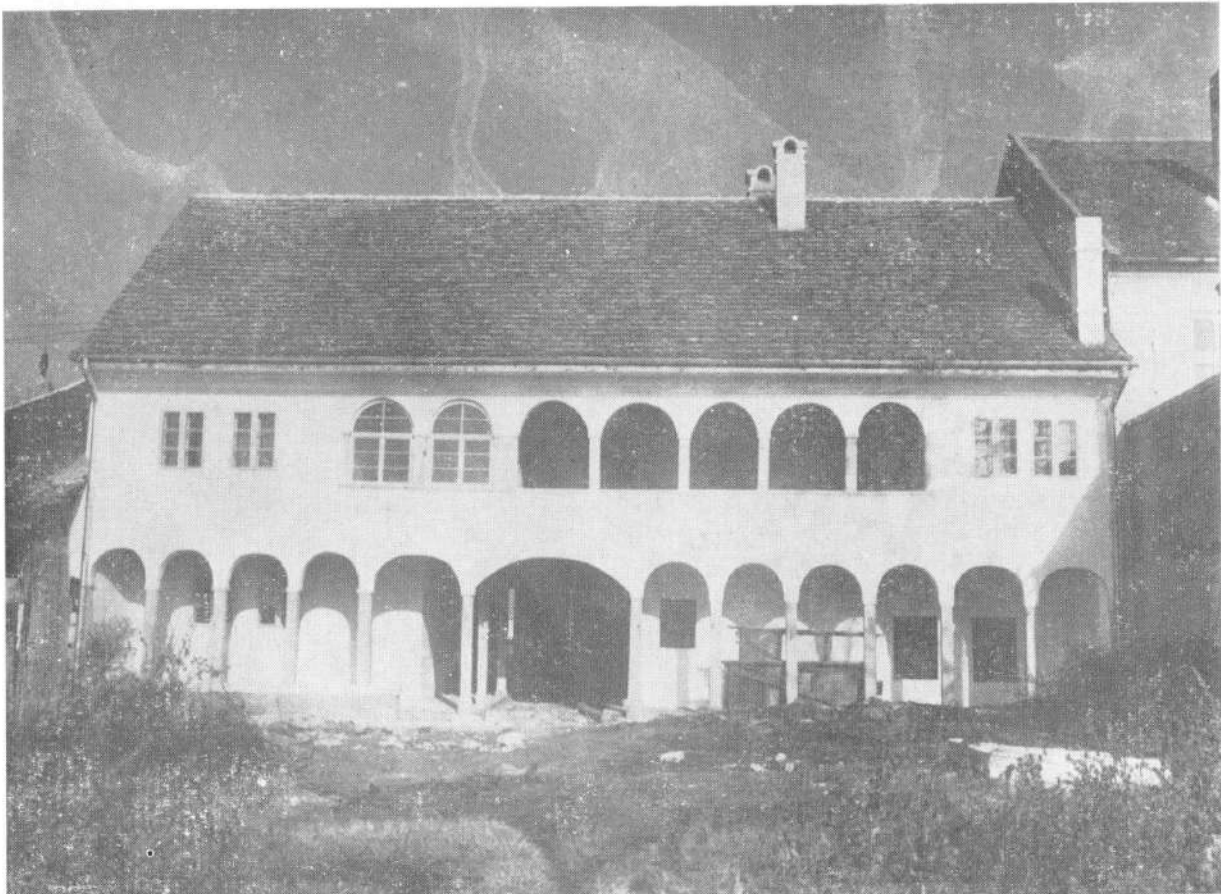
Сл. 16. Конак Димитрија Михаиловића у Обреновцу, око 1835. 16. Maison résidentielle de Dimitrije Mihailović, commerçant d'Obrenovac, élevée vers 1835
