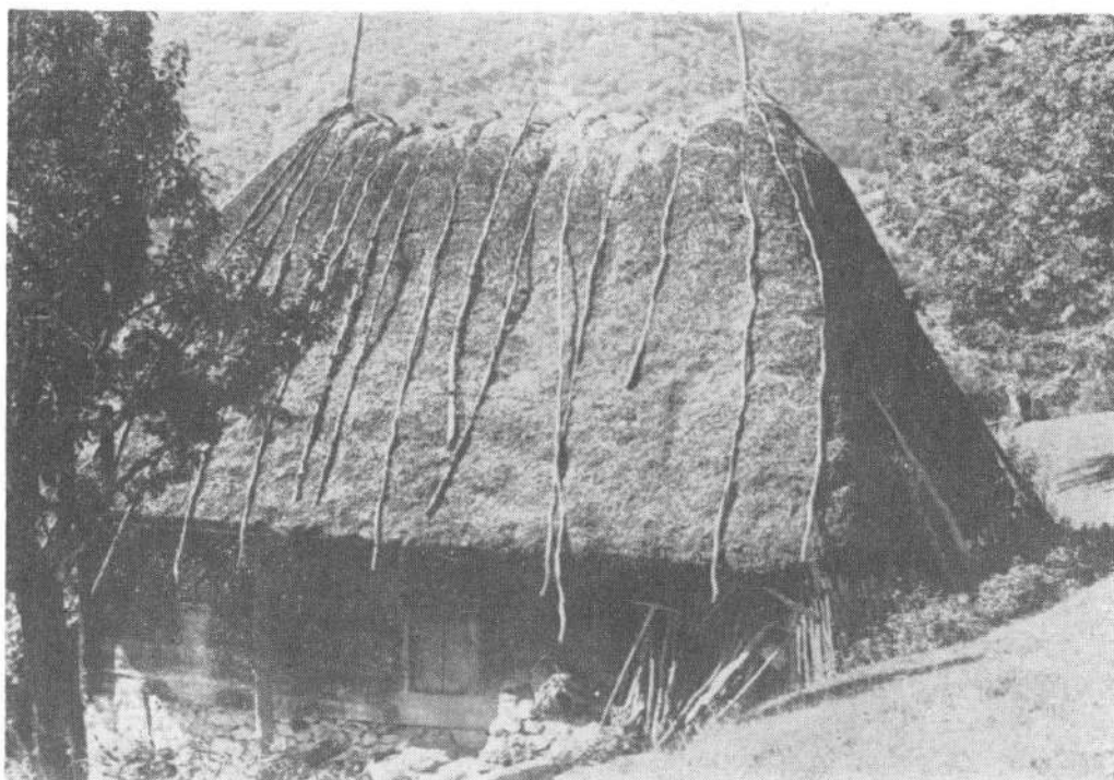
Сл. 2 Кућа брвнара покривена крвином Maison faite de rondins et couverte de chaume
