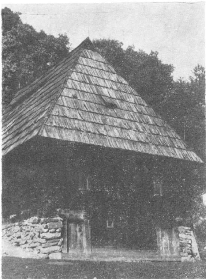
Сл. 1 Кућа брвнара покривена шиндром Maison faite de rondins et couverte de bardeaux
