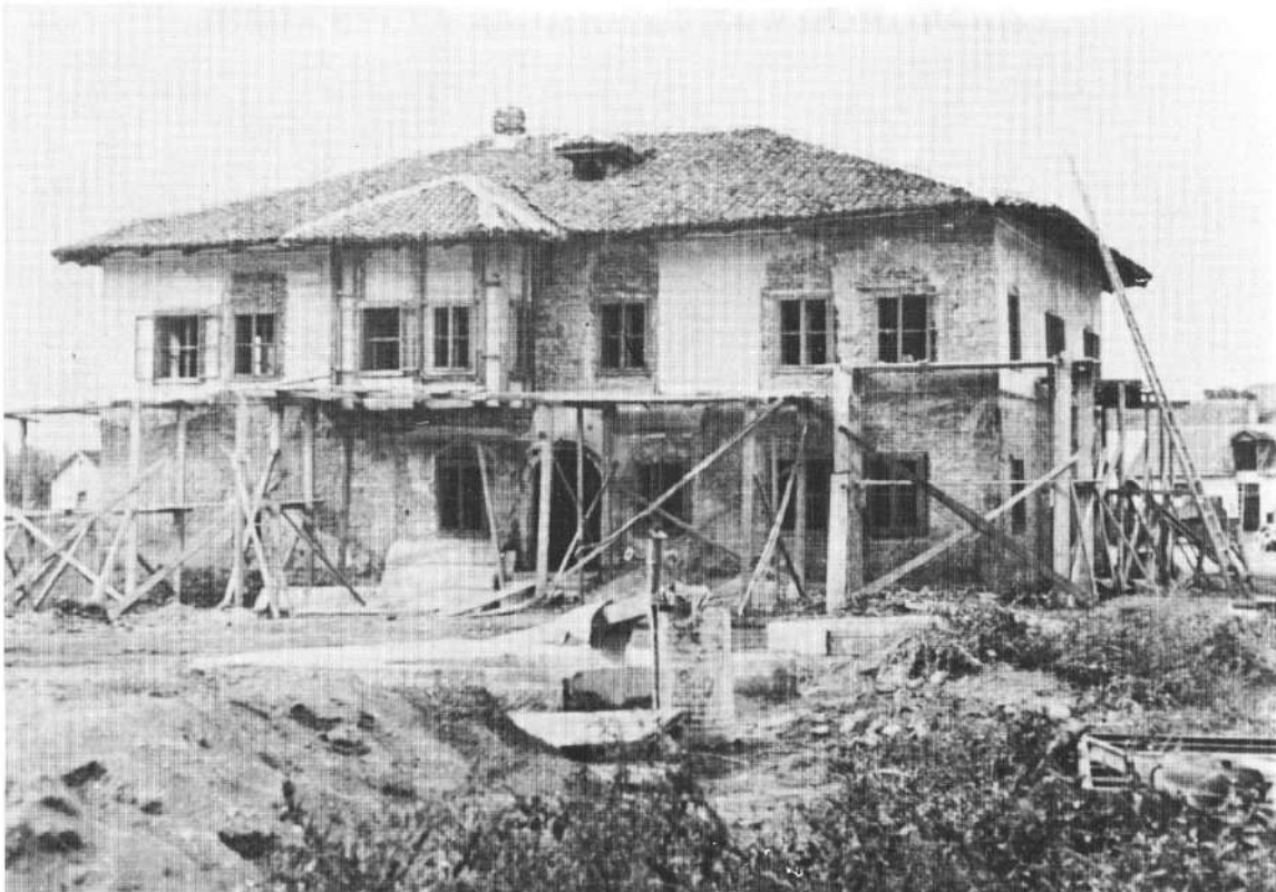
Сл. 2: Реставраторски радови на конаку господара Јована Обреновића
