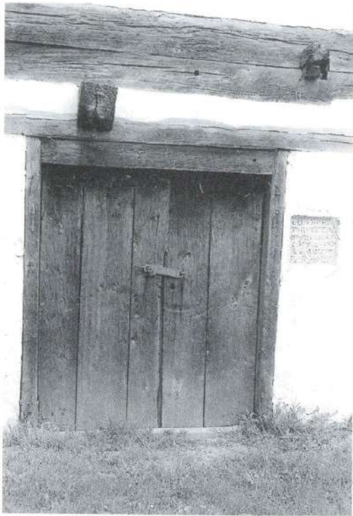
Сл. 5 Подрумска врата и камена плоча са натписом, конак Сретена Чолића (фото: Марко Бојовић)
