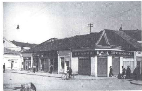
44. Трговина на углу после реконструкције (1950)
