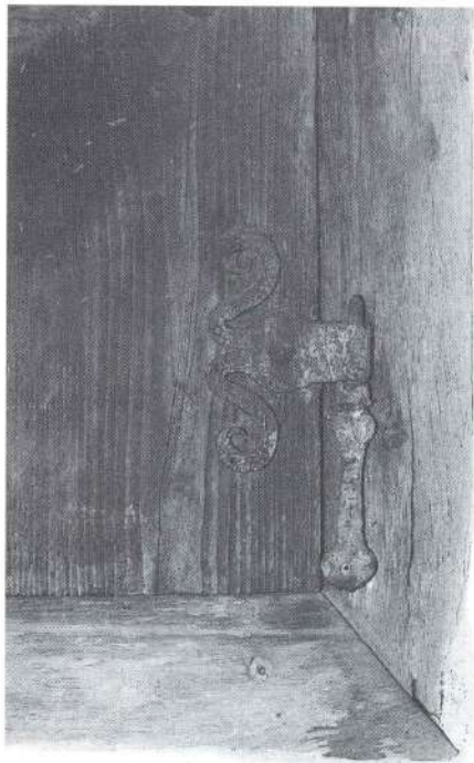
Сл. 7 Деталј коване шарке на дрвеном капку прозора, конак Сретена Чолића (фото: Марко Бојовић)
