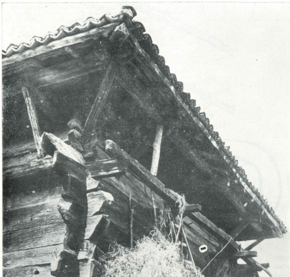
Сл. 15 Велики испусти брвана на угловима горњег подрума служили су као косици преко којих су стављене тање греде на којима се сушило грожђе и други плодови.
