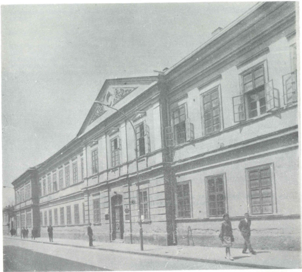
Сл. 4 Изглед главне фасаде
