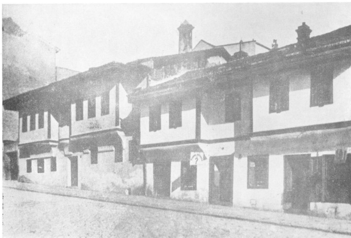
Сл. 6. Ичкова кућа (1820) и кафана „?“ (1823) у Београду 6. La maison de P. Ićko élevée en 1820 et l'auberge »?«, élevée en 1823 à Belgrade
