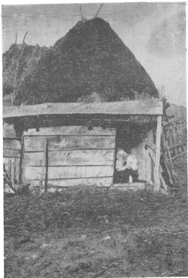
Сл. 13 Телењак Bâtiment réserve aux veaux
