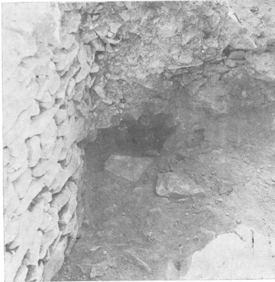
Сл. 1 Трновите Лазине, детали бочног сүхозида, приступне рампе, портала и отвора окна у њему (фото: Д. Мркобрад) Fig. 1 Trnovite Lazine, détails du mur latéral construit en pierres sèches de la rampe d'accès, du portail et de l'orifice du puits
