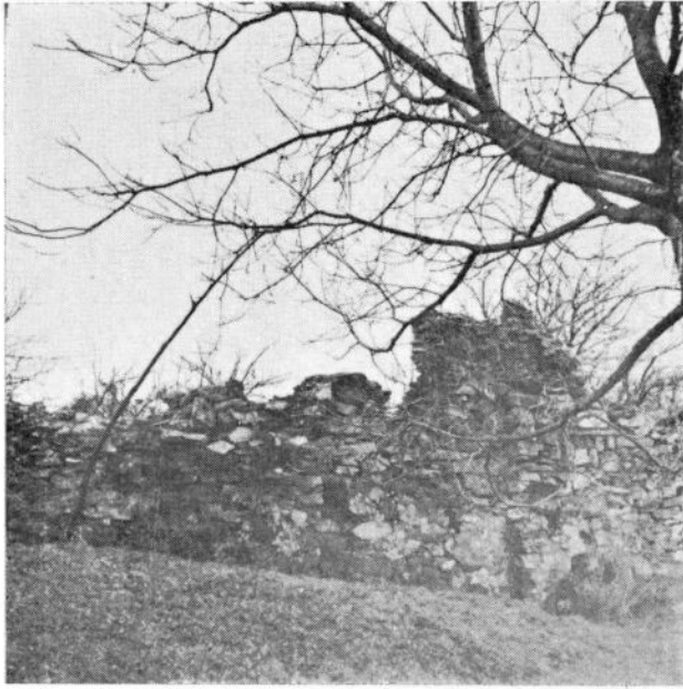
Сл. 3 Рушевине цркве на Руднику, изглед са севера
