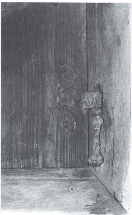
Сл. 7 Детаљ коване шарке на дрвеном капку прозора, конак Сретена Чолића (фото: Марко Бојовић)
