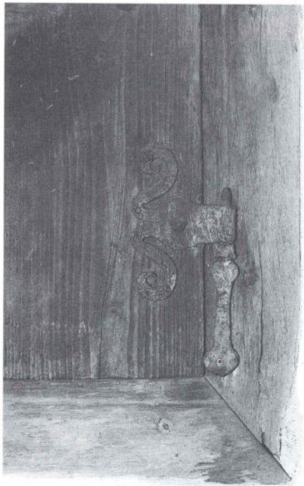
Сл. 7 Детаљ коване шарке на дрвеном капку прозора, конак Сретена Чолића (фото: Марко Бојовић)
