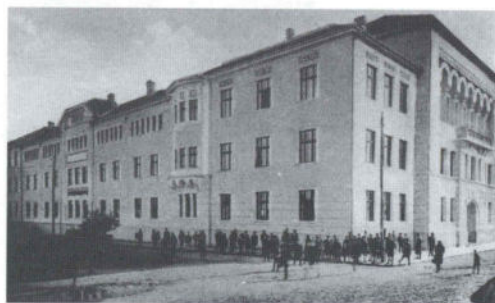
13. Фасада Гимназије из Мутапове улице
