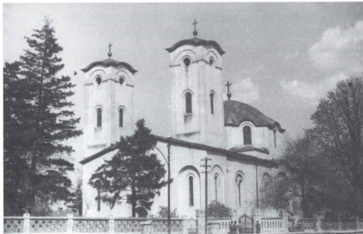
6. Западна фасада чачанске цркве (око 1960)
