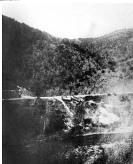
Сл. 3 Срушени воз у Овчарско-кабларској клисури при одступању Аустријанаца 1918. године (извор: Архив Србије - Београд, фонд : 3. Ф, К-6, инв. број 134/18
