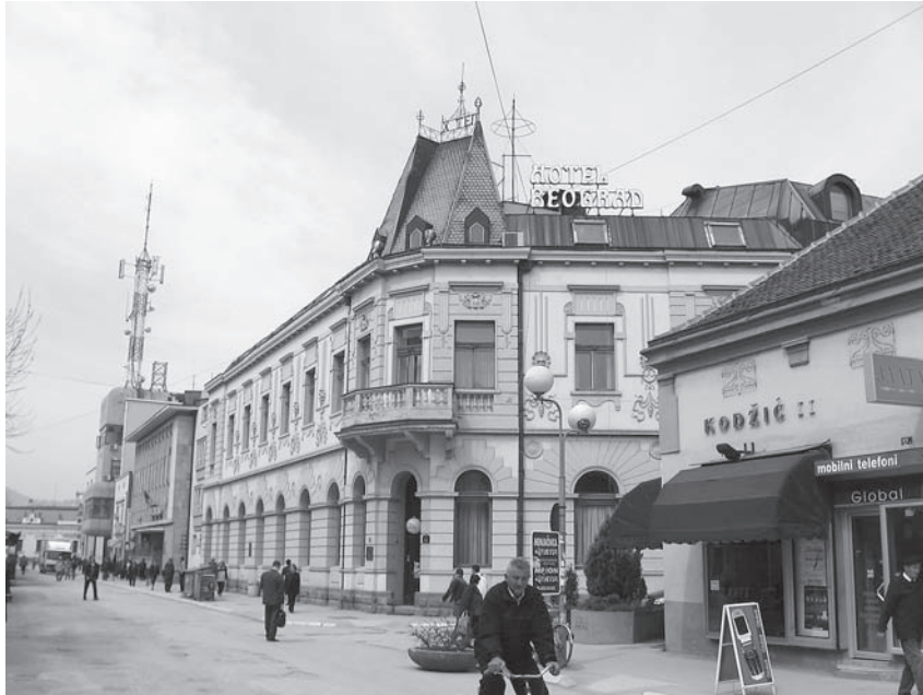
Поглед из главне улице
