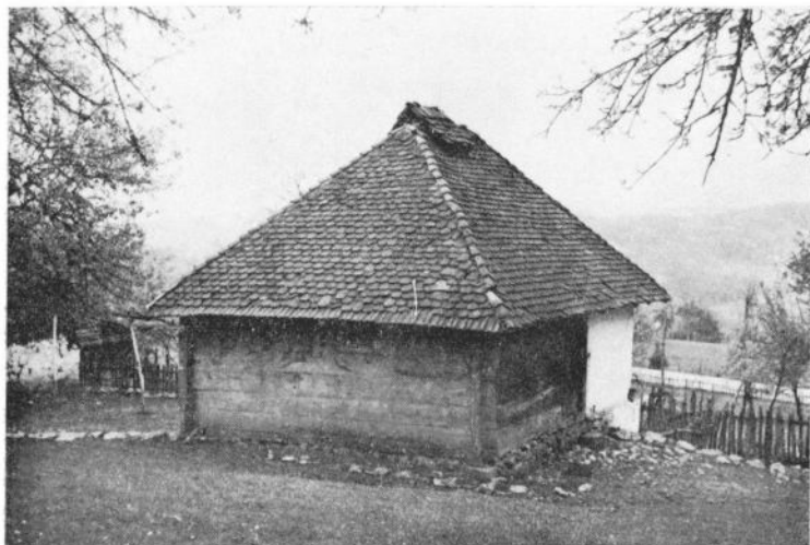
Сл. 33. Кућа полубрвнара Јовише Дуњића, изглед са северозапада, Негришори
